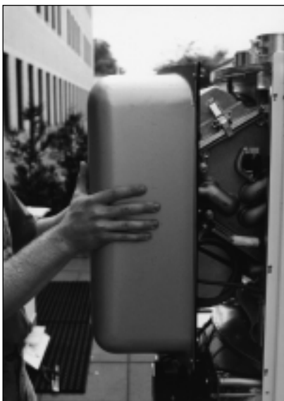
Figuur 3.2.1 Demonteren ventilatiekast
